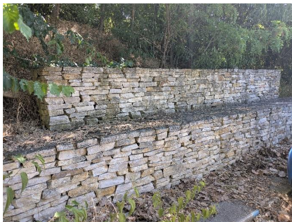
Figure 25 : Muret en pierres sèches
