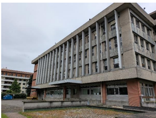
Figure 14 : Bâtiment rue Sébastopol
