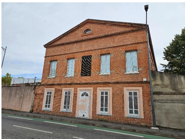
Vue depuis l'extérieur du site
