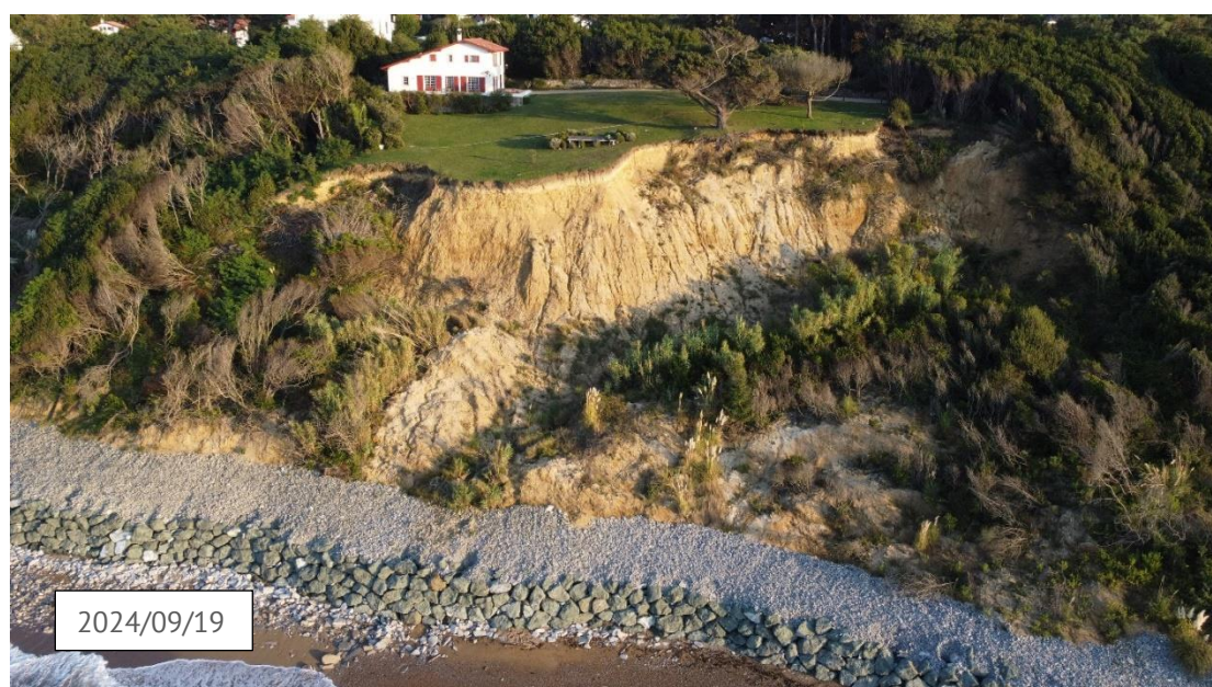
Figure 5 : Vues aériennes du secteur Ouest de la zone projet entre 2022 et 2024 (Source : ANTEA Group)
