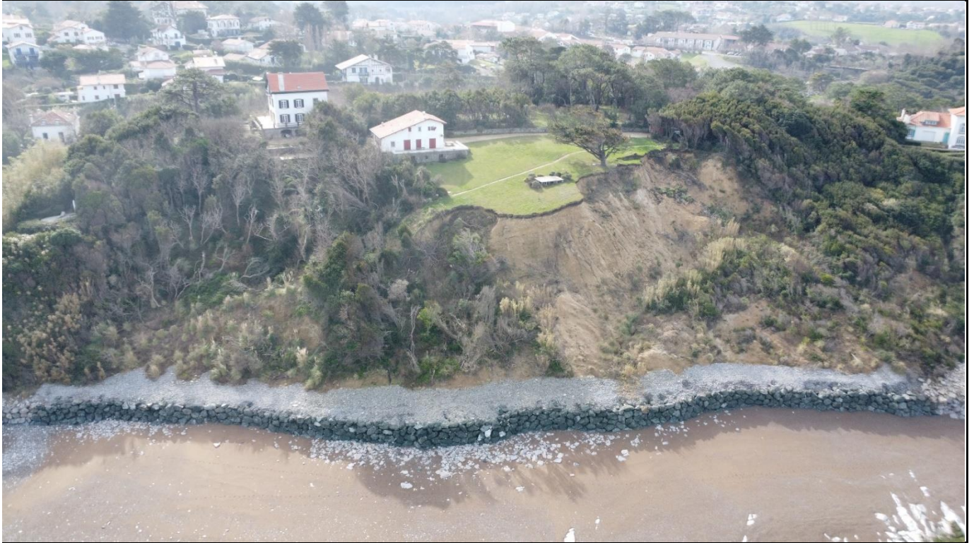
Figure 9 : Vue arienne de l'ouvrage de protection de pied (Source : ANTEA Group)
