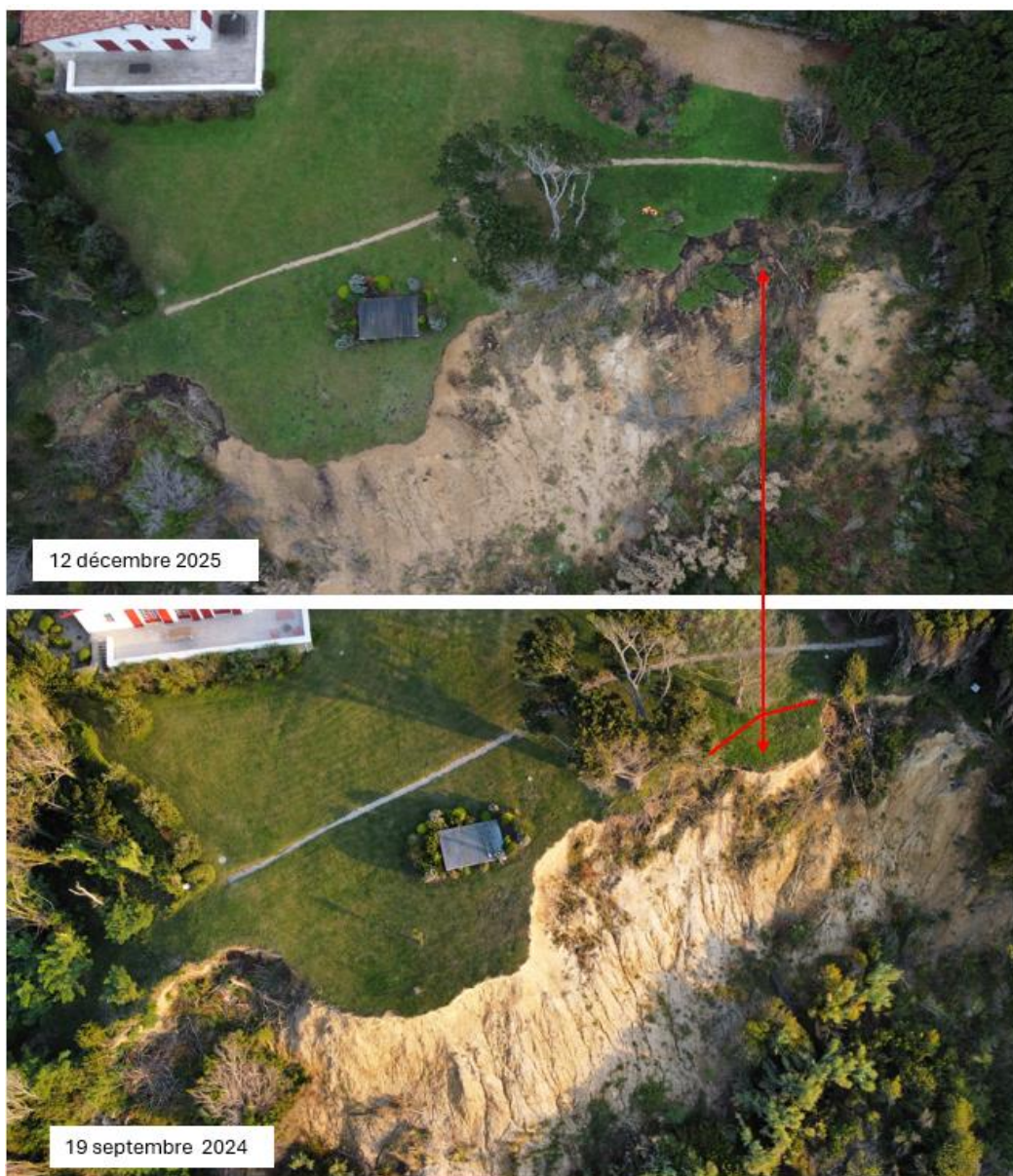
Figure 7 : Glissement du plateau sur la zone Ouest en 2025 (Source : ANTEA Group)
