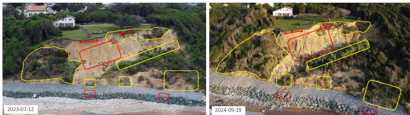
Figure 33 : Phénomène d'érosion sur l'emprise projet (Source : ANTEA Group)
