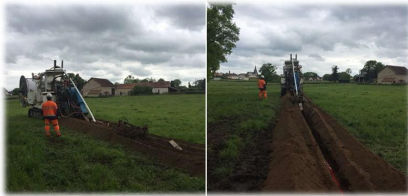
FIGURE 3 : EXEMPLE DE CHANTIER D'ENFOUISSEMENT D'UN RESEAU ELECTRIQUE EN TERRES AGRICOLES (SOURCE : CEGELEC INFRA)
