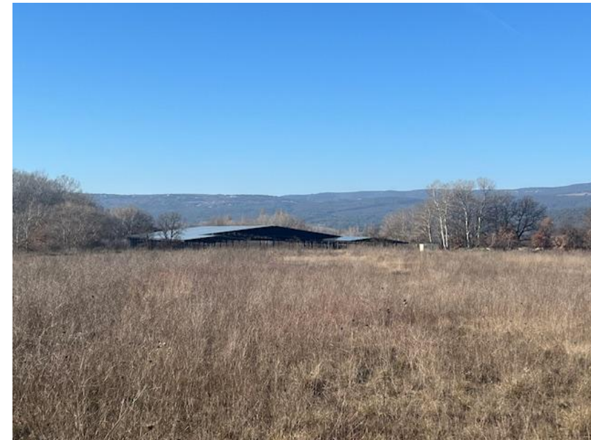
Vue du bâtiment agricole au nord
