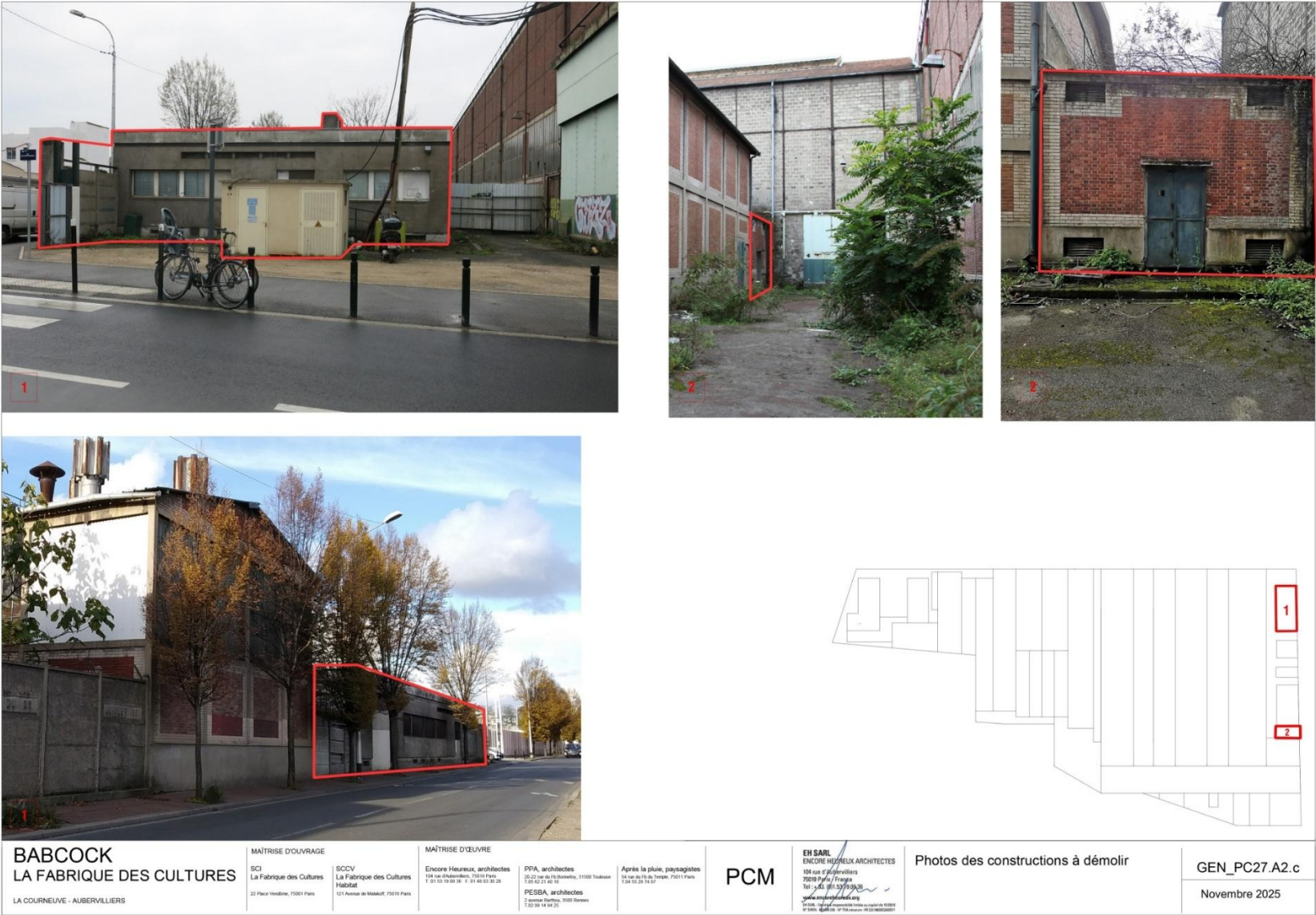
Figure 6 : Photographies des constructions à démolir au sein des halles 2/2
