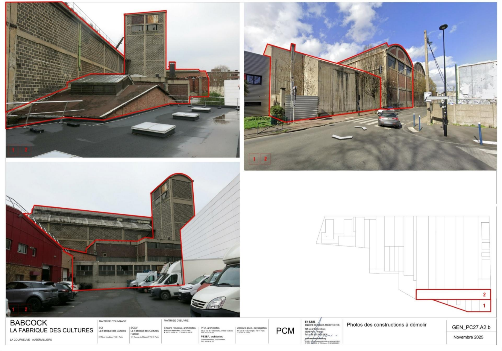
Figure 5 : Photographies des constructions à démolir au sein des halles 1/2
