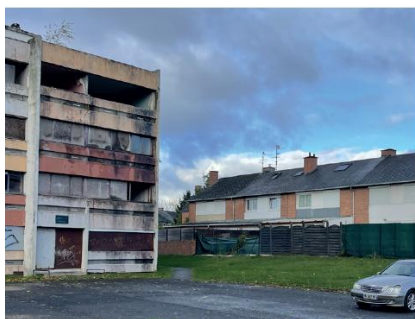
Figure 11: Un adressage sur des maisons individuelles en R+1+combles
