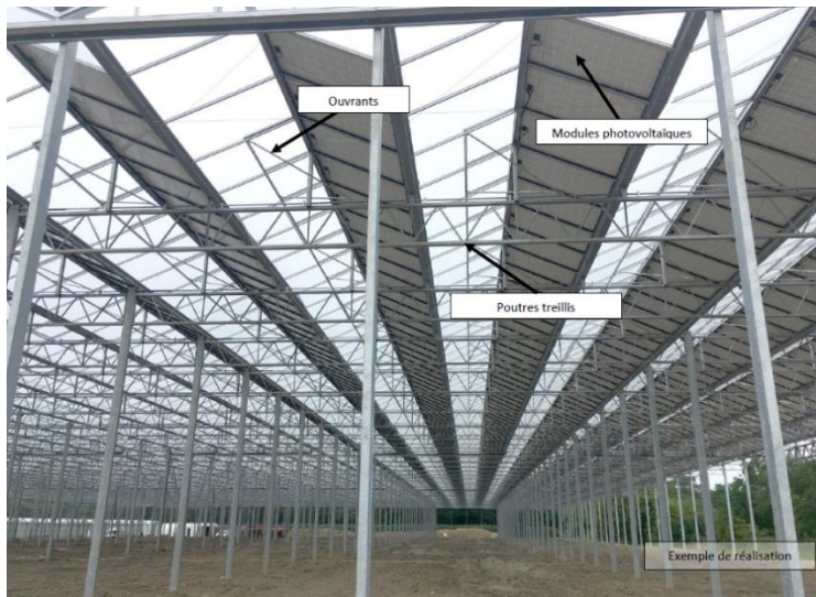
Exemple de la structure (réalisation)
