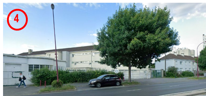
Ecole - Vue depuis la rue Emile Zola (google street view – 2025)
