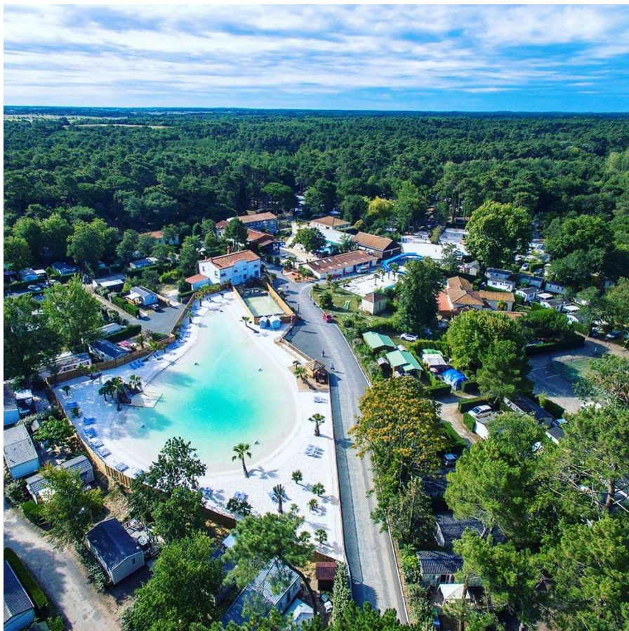
Photo N°1: Vue drone sur la zone centrale/lagon
