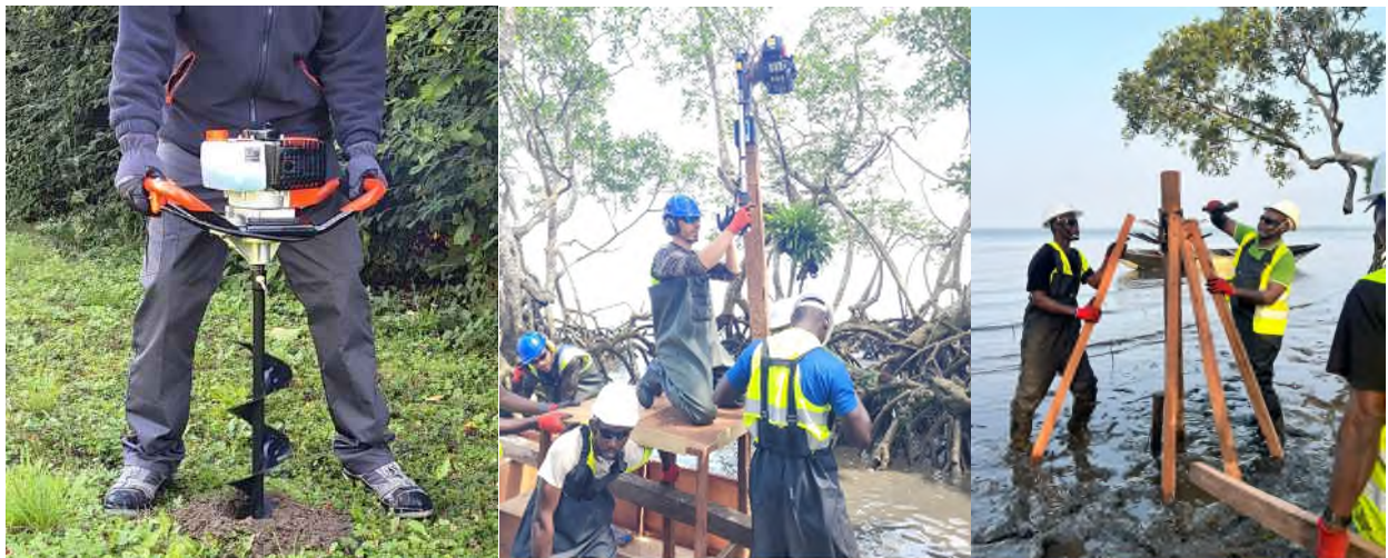
FIGURE 14: SCHEMAS ET PHOTOS DES PHASE DE MONTAGE DES MODULES ROOT (SEABOOST)
