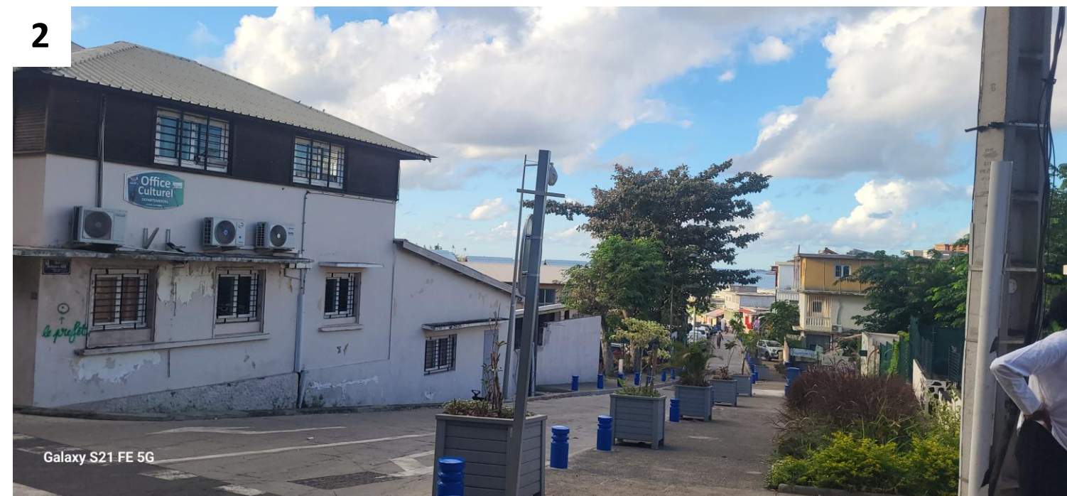
Photographie 2 : Vue du site du projet dans son environnement proche, à l'emplacement des futurs bâtiments E et F – prise depuis l'avenue M'Chindra Saïd (juin 2025)
