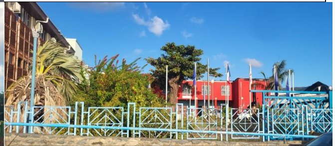
Photo 6 : Vue de l'entrée principale du Conseil Départemental
