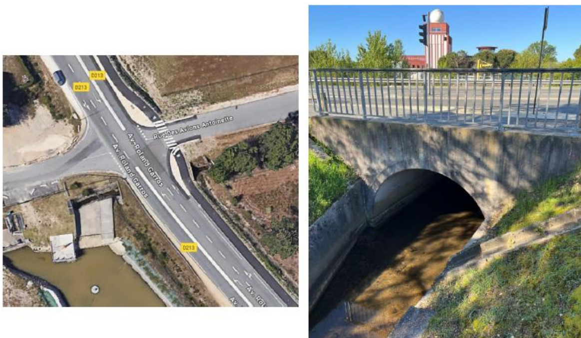
Figure 15 : Point singulier - Passage ouvrage d'eau pluviale
