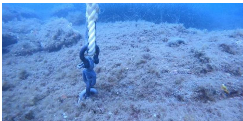
Figure 3 : Exemple de dispositif d'amarrage scellé dans la roche (© Parc Naturel Marin du Golfe du Lion).
