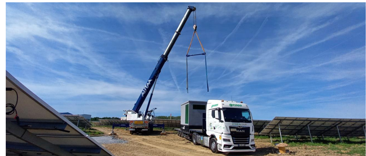
Figure 24 : Installation d'un local technique
