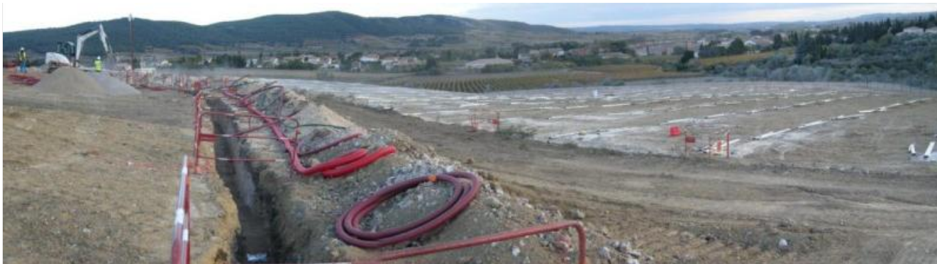
Figure 23 : Travaux de création d'une tranchée
