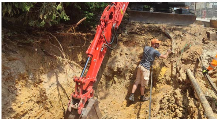
Arrachage de racines à la pelle RCU - Rue du Danemark
