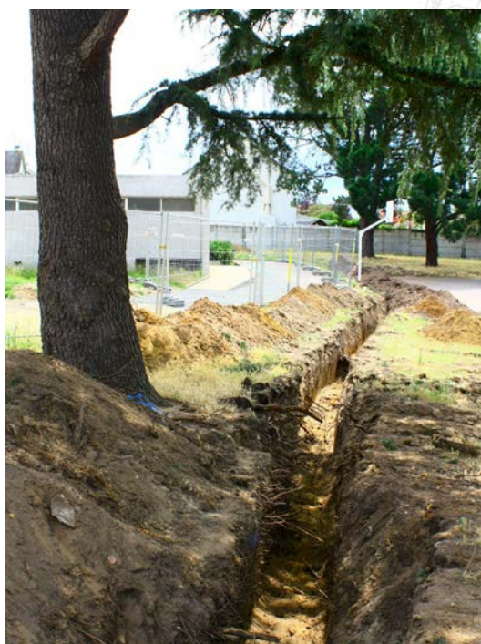
Tranchée en zone très sensible de l'arbre pour le passage de réseaux divers - Quartier Huchepie
