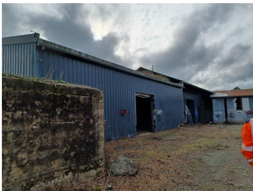
Figure 1 : Emplacement prévu pour l'implantation de la nouvelle chaufferie sur l'ancien site industriel.
