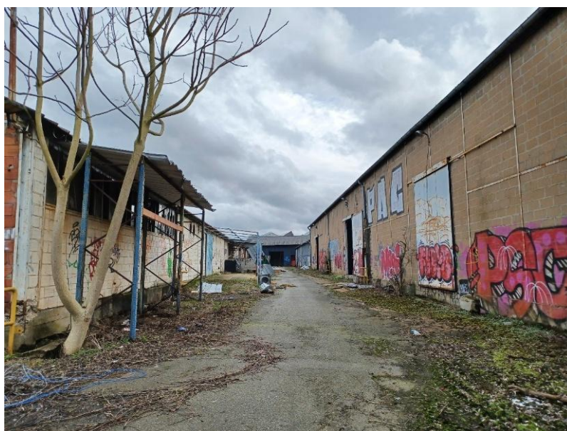
Figure 2 : En face - emplacement prévu pour l'implantation de la nouvelle chaufferie (voir Figure 1). Sur les côtés : bâtiments démolis.
