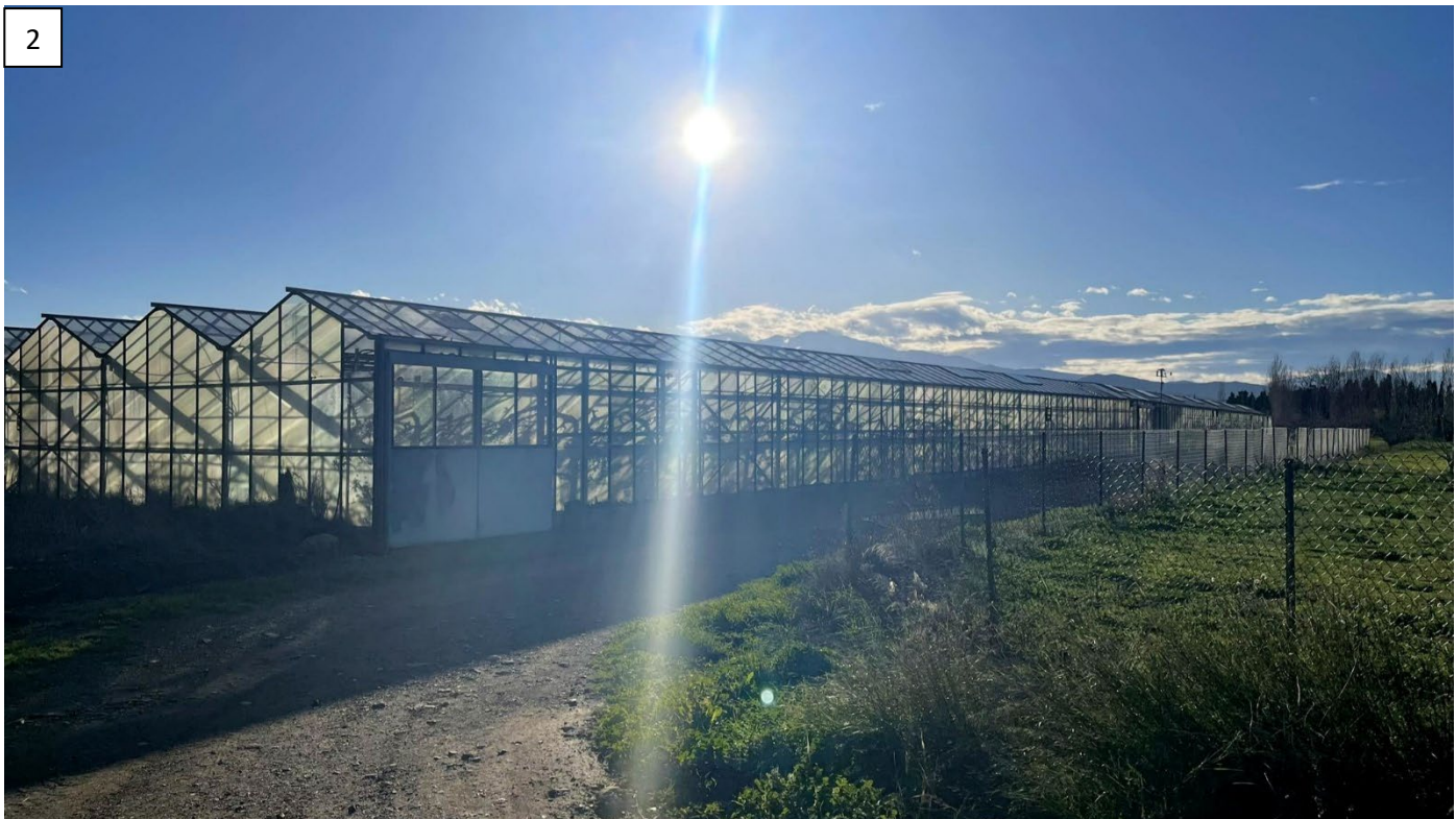
Vue 2 : vue sur le site du projet depuis le chemin rural dit Cami-del-Palaus
