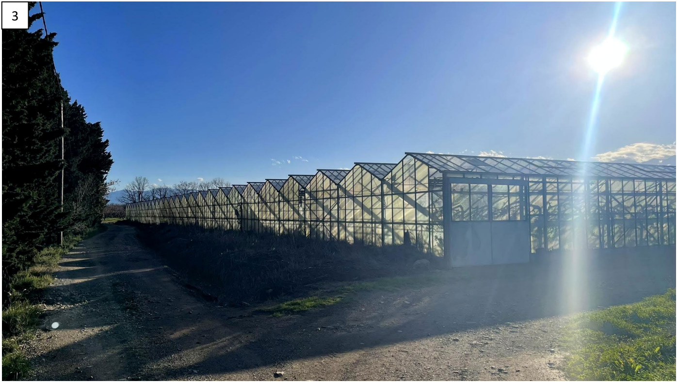
Vue 3 : vue sur le site du projet depuis le chemin rural dit Cami-del-Palaus
