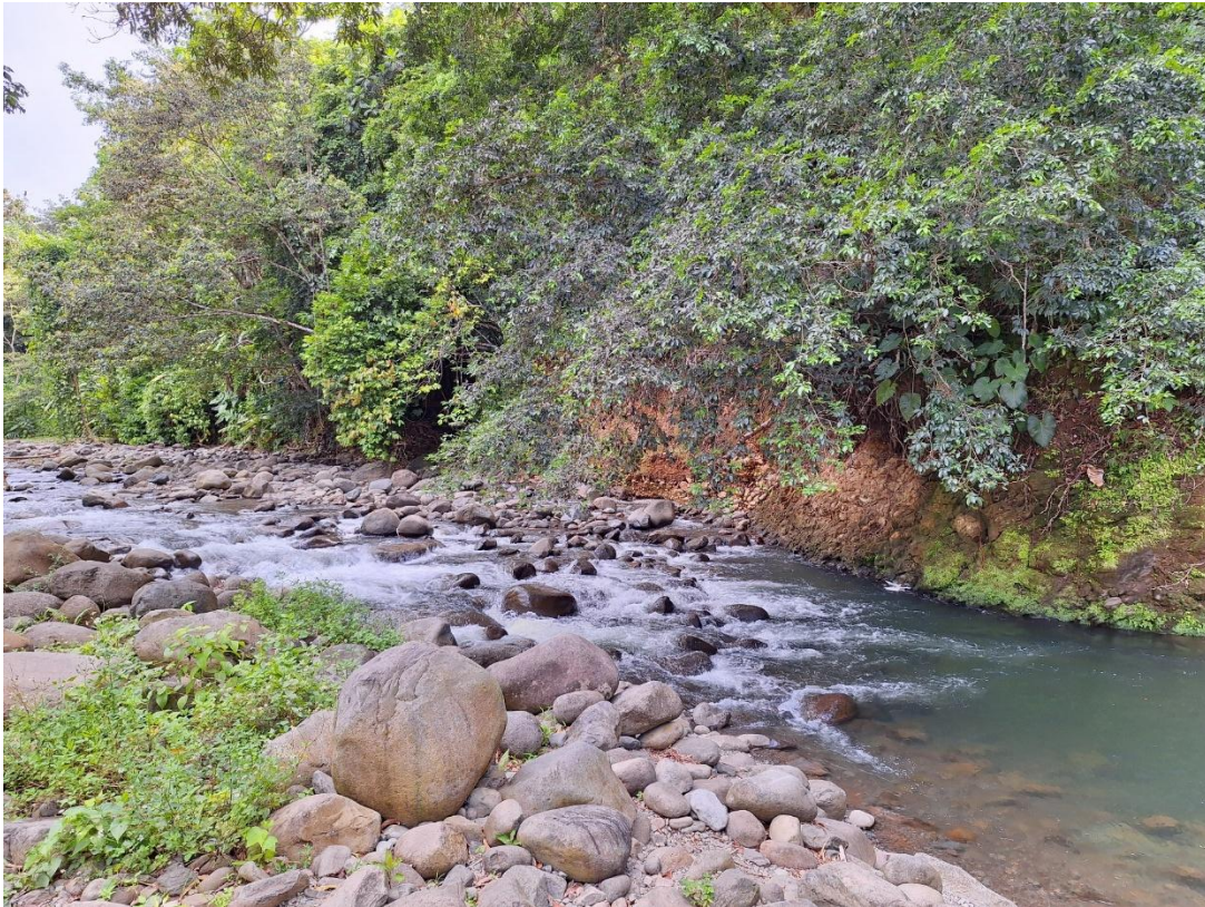
Zone d'implantation envisagée pour le seuil de prise d'eau
