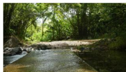
Deuxième gué menant à la zone protégée du captage AEP de la rivière Moustique
