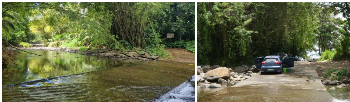
Figure 35 : Gué du captage d'eau potable, Gué de Trianon
