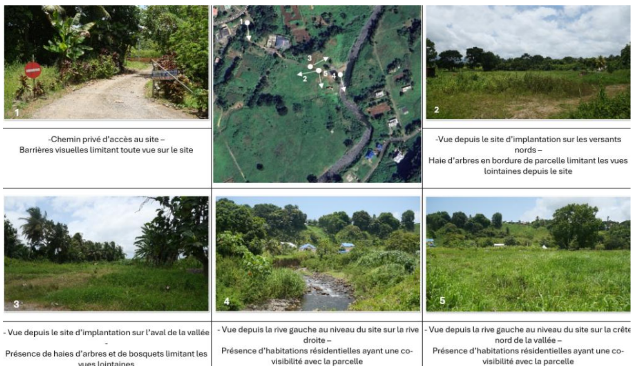
Figure 24 : Planche illustrative – Abords immédiats de l'usine hydroélectrique
