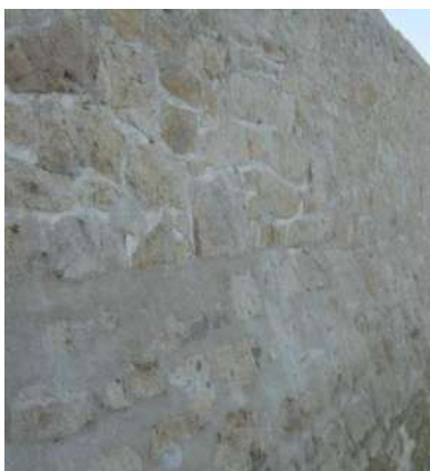
Figure 16 : Exemple de réfection de maçonneries
