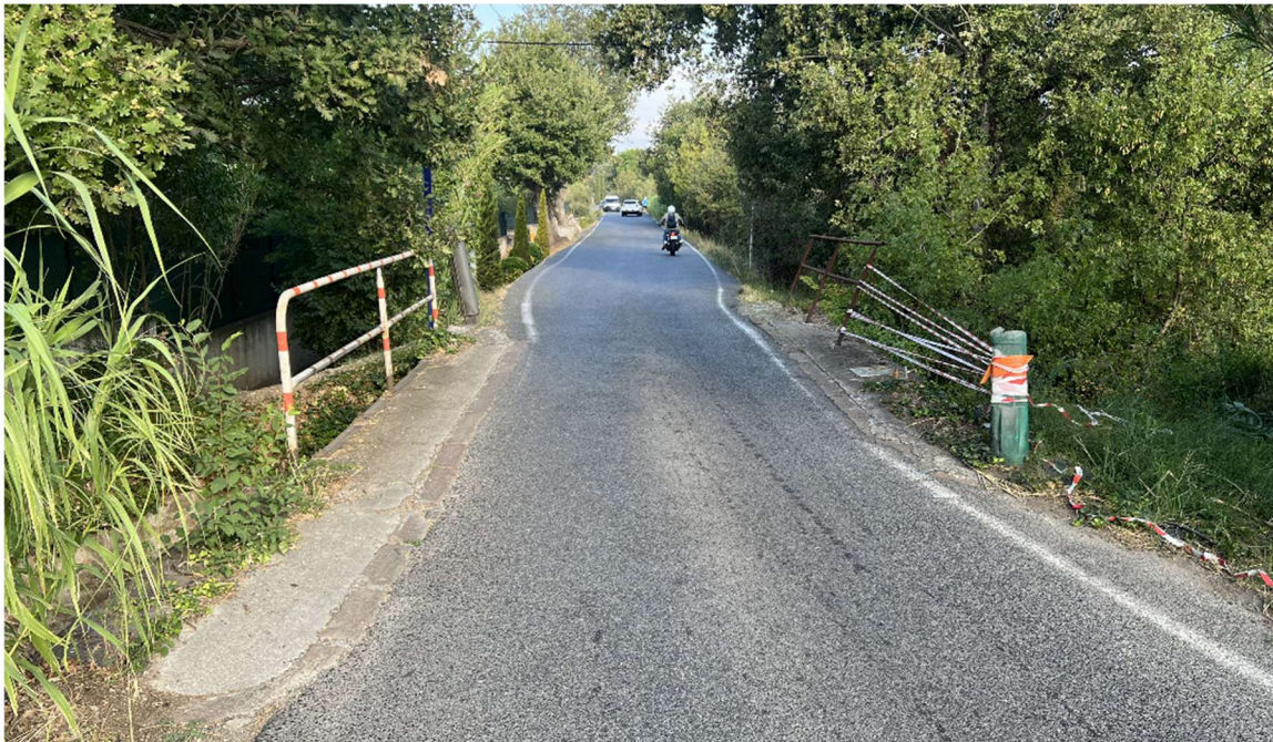
Figure 3 : Photo CFPON 015 – Voie portée
