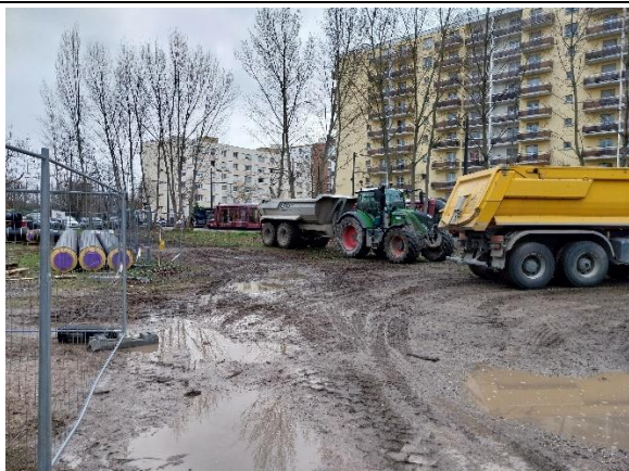
Photographie 1 : Entrée du site vue vers le sud
