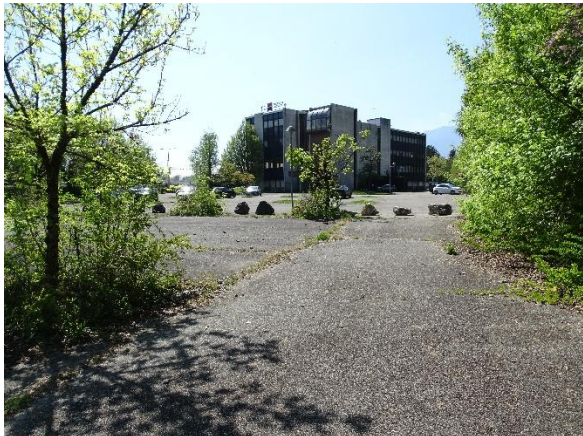
Secteur actif vu depuis l'est du site
