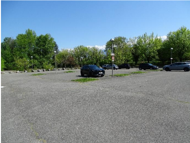
Vue d'ensemble du parking depuis l'accès nord
