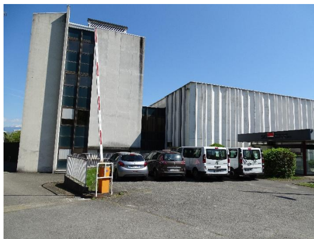
Bâtiment vu depuis la rue des Aiguinards
