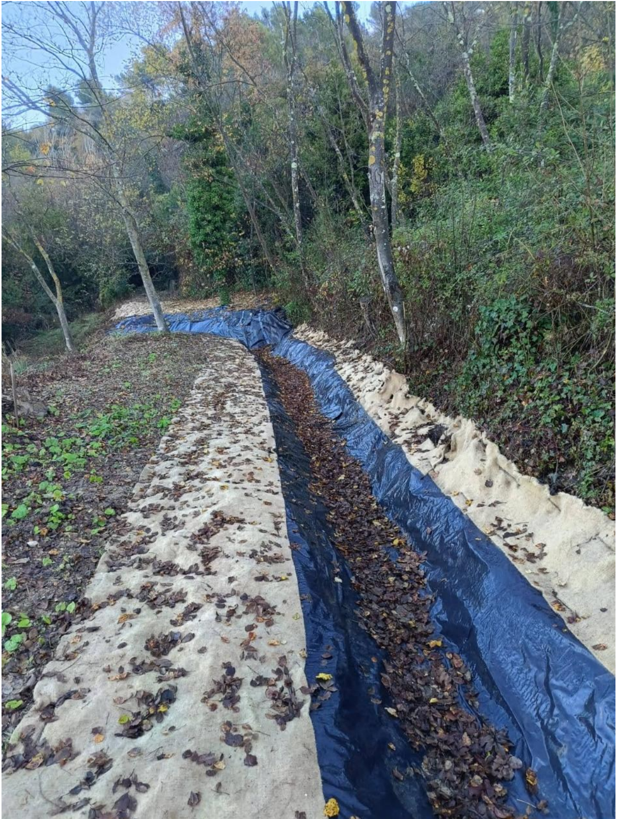
FIGURE 13 : CANIVEAU DE DRAINAGE COTE OUEST
