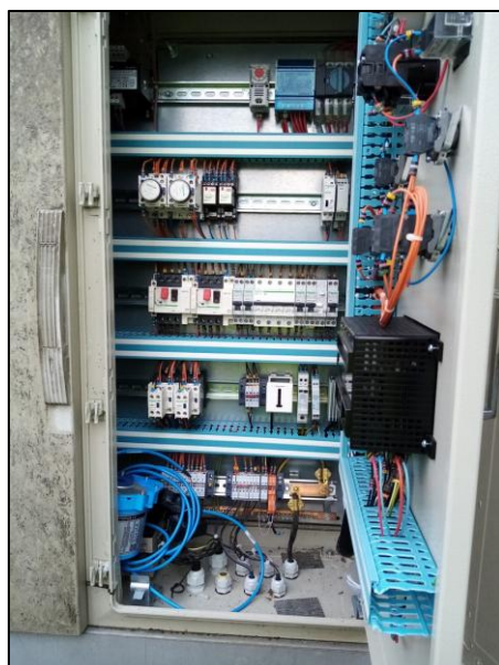
Photo 3 : Mesure du temps de fonctionnement sur le PR Collège
