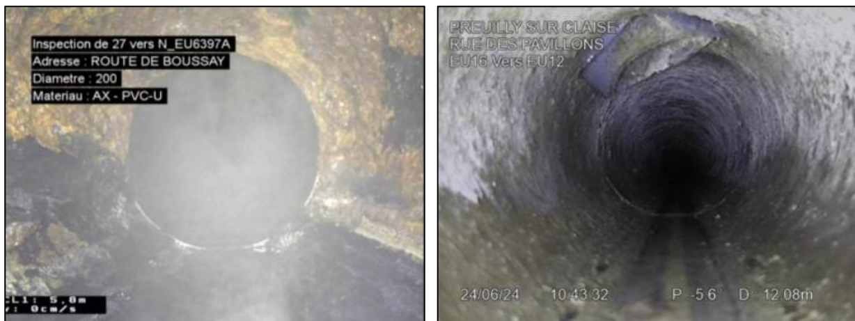
Photo 9 : Changement de matériaux du collecteur entre les regards N_EU6397A > N_EU6482 (à gauche) et branchement pénétrant entre les regards N_EU6505 > N_EU6506
