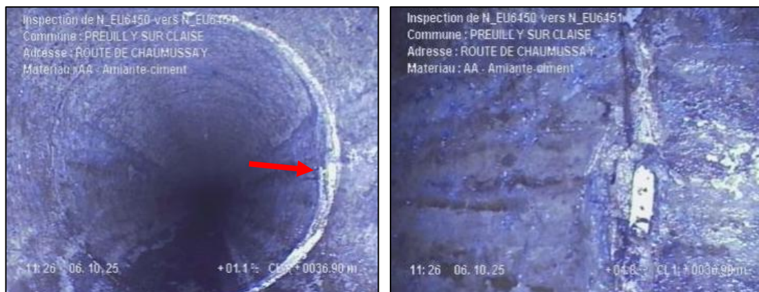
Figure 40 : Épaufrure identifiée sur le collecteur entre les regards N_EU53 > N_EU54
