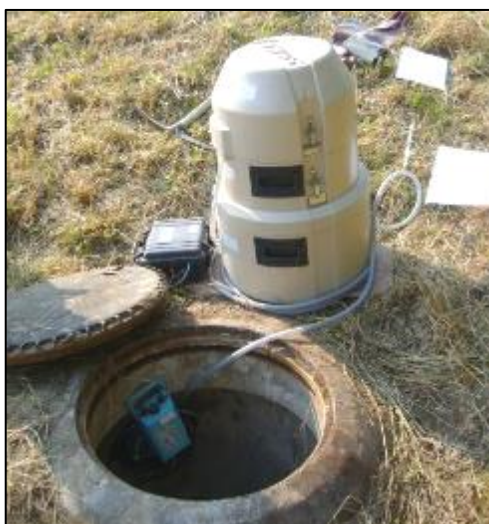
Photo 15 : Préleveur autonome pour la réalisation de bilan de pollution sur 24 heures
