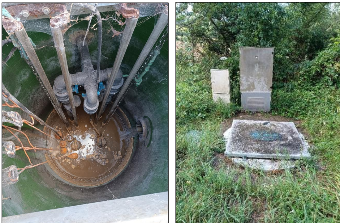
Photo 4 : PR Rue des Varennes
