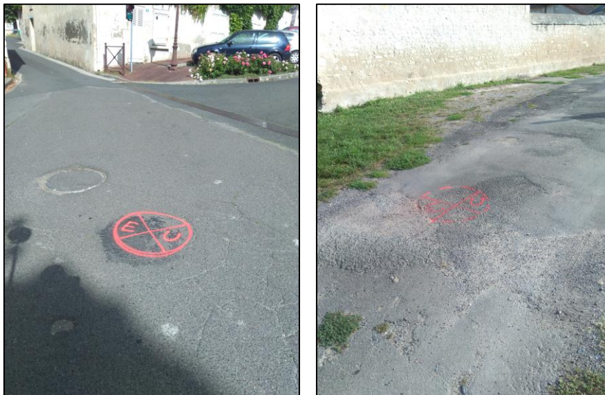
Photo 6 : Regard eaux traitées regard N°4 et N°23
