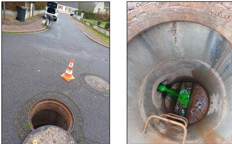
Figure 25 : Test des avaloirs publics à la fluorescéine
