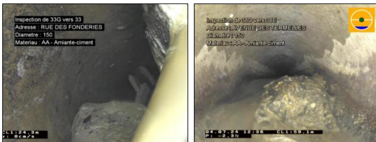
Figure 11 : Dépôt dur générant une obstruction entre les regards N_EU33G > N_EU33 (à gauche) et entre les regards N_EU38D > N_EU38E (à droite)
