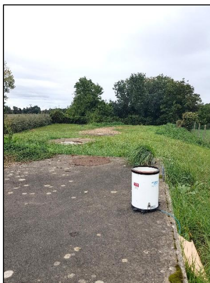
Photo 2 : Pluviomètre à auget installé au niveau de la STEU Le Grignon
