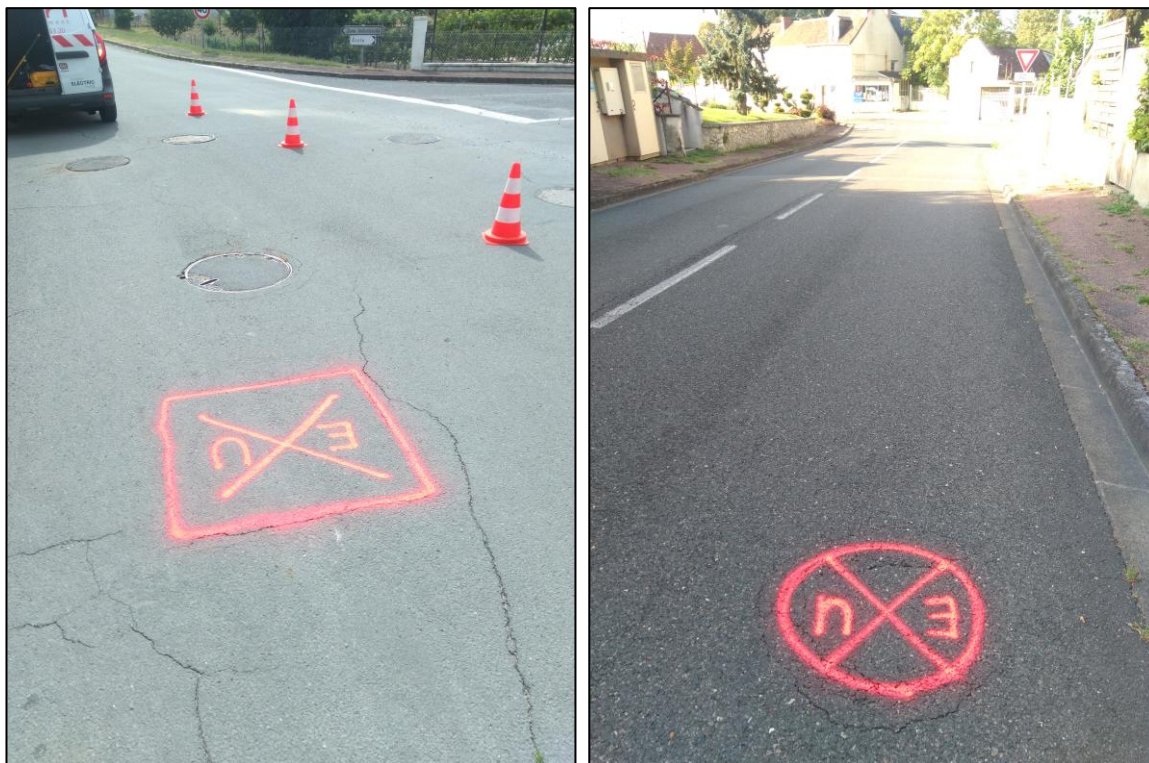
Photo 17 : Regards eaux usées N_EU9152 et N_EU8718 situés sous enrobé
