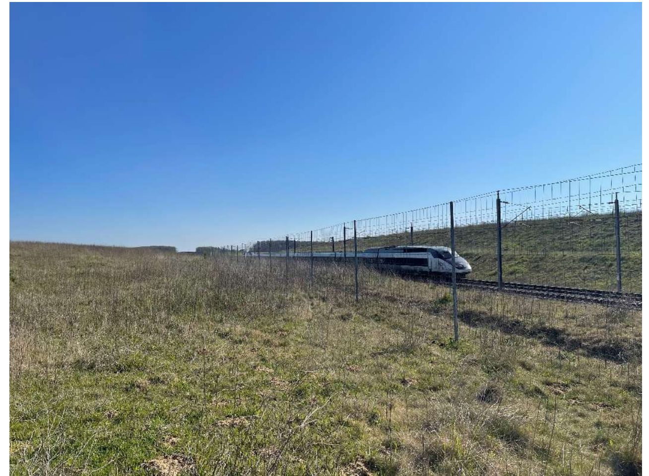
Illustration 2 : Photographie de la ligne de chemin de fer passant au sud du site d'étude (Source : EREA INGENIERIE)
