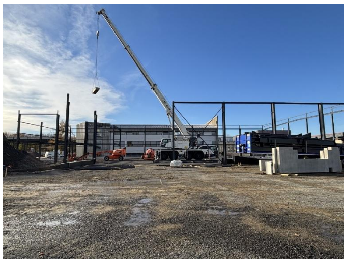
Montage de la charpente métallique – durée 1,5 mois
