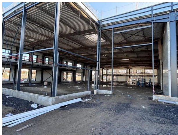
Montage de la charpente métallique – durée 1,5 mois
