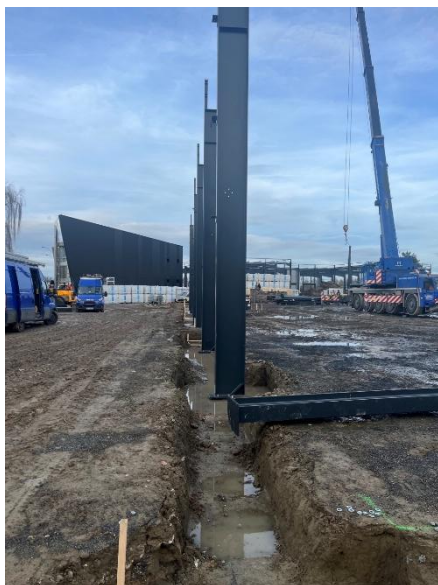
Montage de la charpente métallique – durée 1,5 mois
