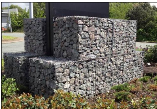
Figure 32 : Exemple de muret en gabion (Source : TCS Geotechnics)
