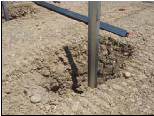
Figure 30 : Types de fondation - pieux battus (Source : Guide MEDDTL 2011 – NCA, 2015)
