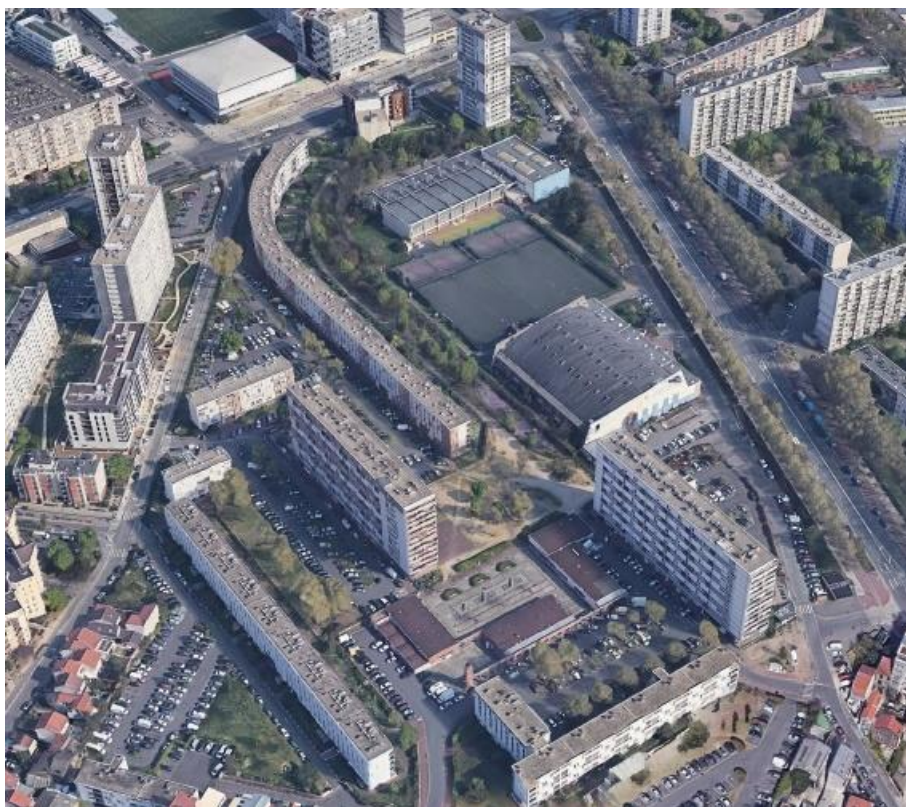
Figure 4 : Vue aérienne du quartier des Courtilles (état initial avant les premières démolitions) (Source : CITALLIOS)
