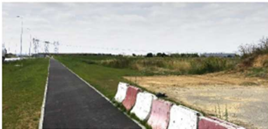
2. Vue de la nouvelle traversée piétonne le long de la rue du Fortin
