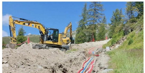
Figure 3: Illustration du type de tranchée réalisé
