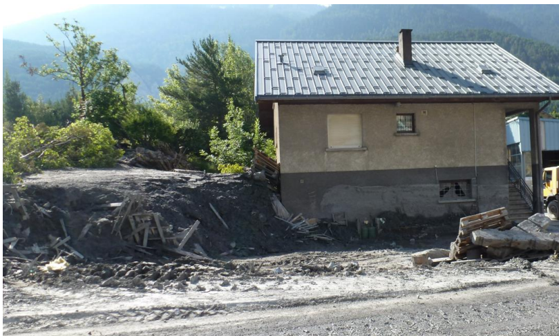
Figure 35 : crue de 2014, 1m80 de dépôt au droit de la maison rive gauche
