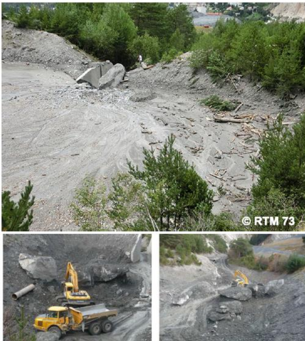
Figure 11 : plage de dépôt suite à la crue de 2014 source ONF-RTM et ETRM 2018
