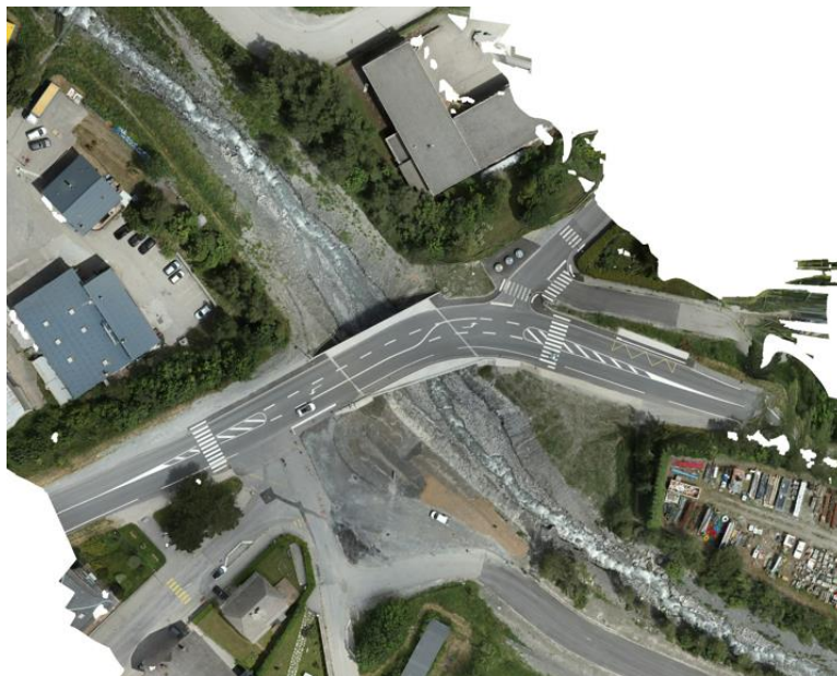
Figure 20 : Orthophoto au droit du pont de la RD (VR3D)
