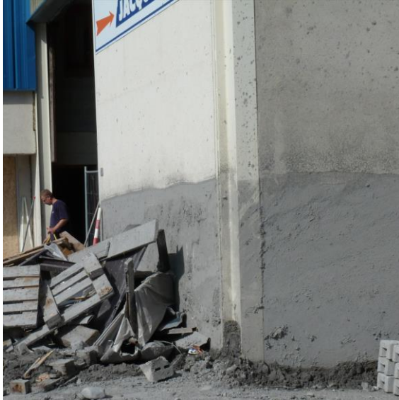
Figure 36 : crue de 2014 entre 1m80 et 1m de dépôt dans l'entrepôt d'autocar rive gauche
