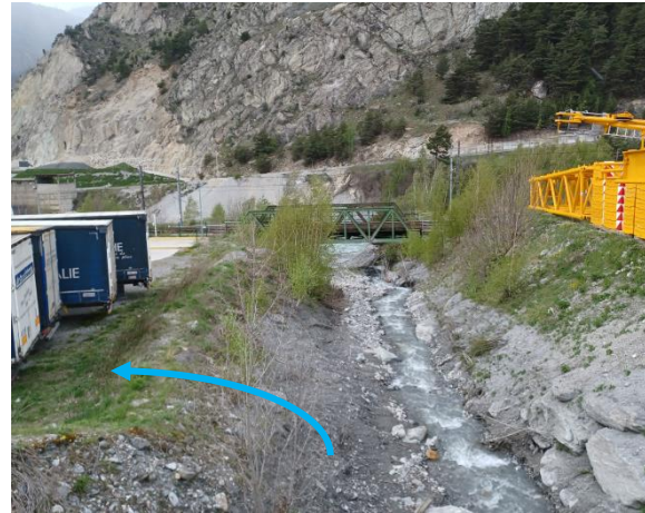
Figure 54 : Vue de l'aval de la passerelle, zone d'abaissement de la ligne de crête en rive gauche
