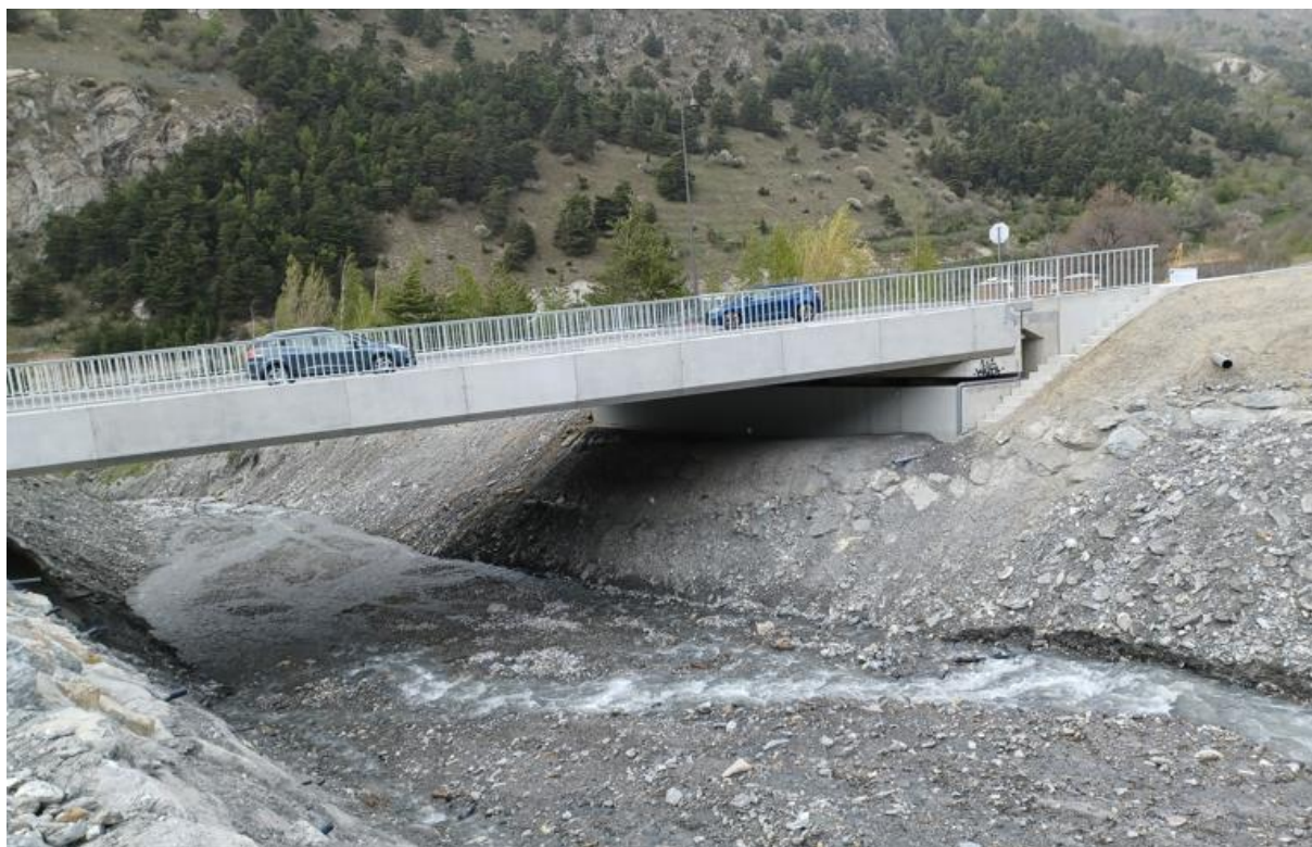
Figure 18 : Pont de la RD 1006 avril 2024
