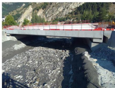
Figure 7 : Amont du nouveau pont de la RD1006 le 14/08/2023
