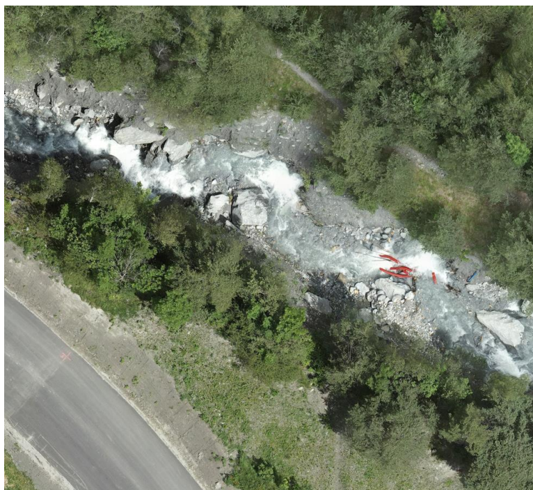
Figure 9 : zone de « gros bloc », anse d'érosion visible en rive droite et restes d'une canalisation traversante
