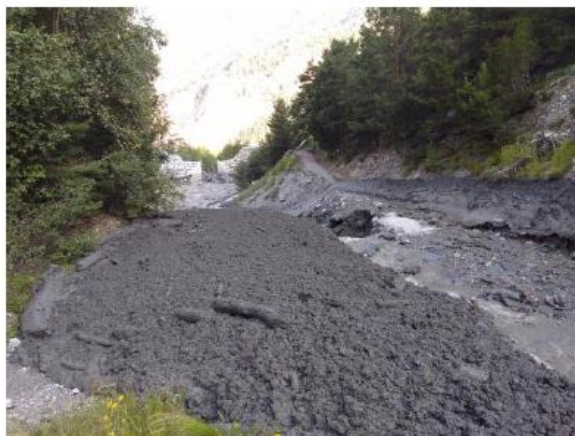
Figure 5 plage de dépôt à la suite de la crue de 2023 (RETEX SPM)
