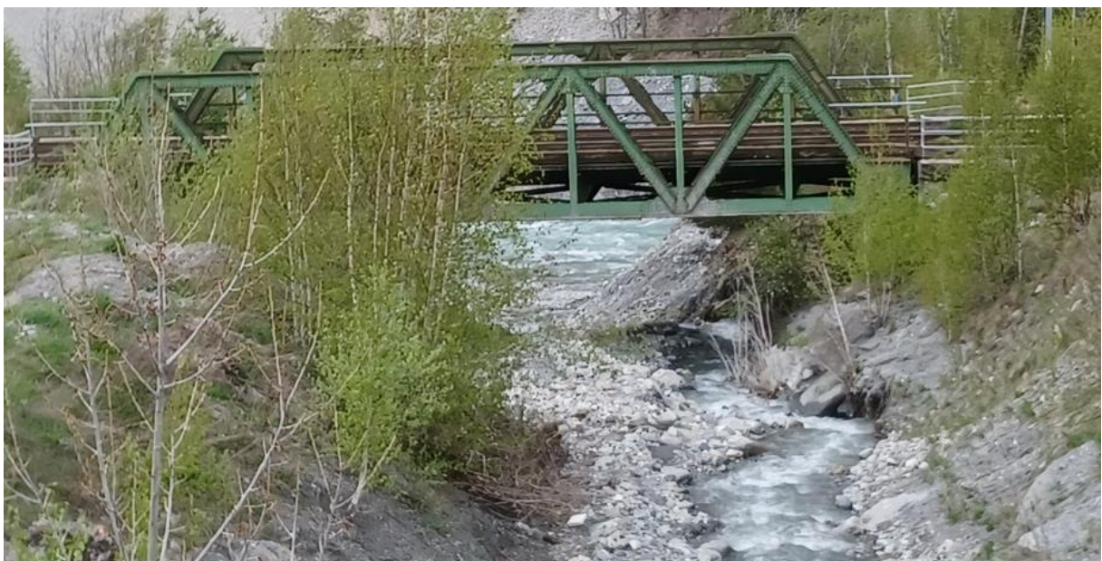
Figure 22 Pont SNCF, avril 2024
