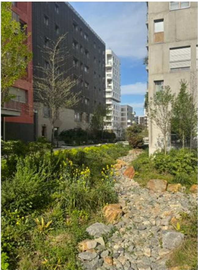
Figure 17 Exemples de noues en pied d'immeuble (D&A, AMO Urbanwater)
