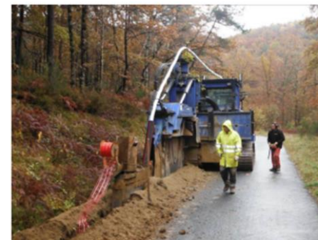
Figure 29 : Pose de câble à la trancheuse
