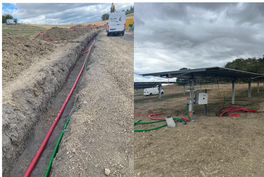
Figure 28 : Illustration de tranchées de câbles (source : TSE)
