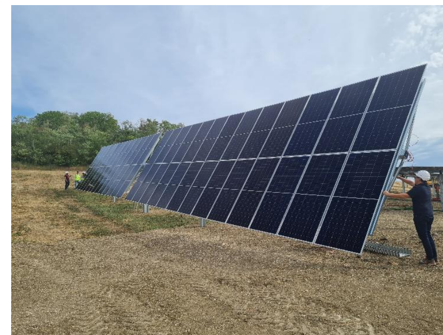
Figure 19 : Installation des panneaux (source : TSE)
