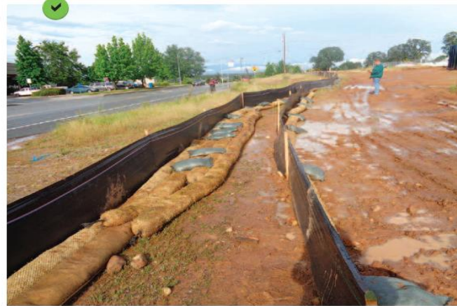
Double barrières de rétention installées à la périphérie de l'emprise du chantier et conjuguées à des boudins en fibres de paille maintenus au sol par des sacs de graviers.
