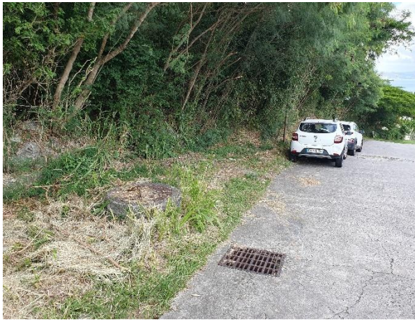
29 – Collecte des EP sur la rue du Fort d'Alet
