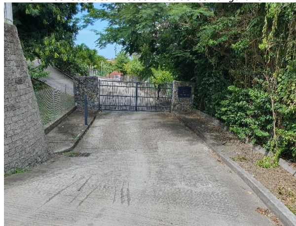
34 – Collecte des EP sous la résidence Tangarane
