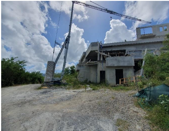
15 – Chantier en cours
