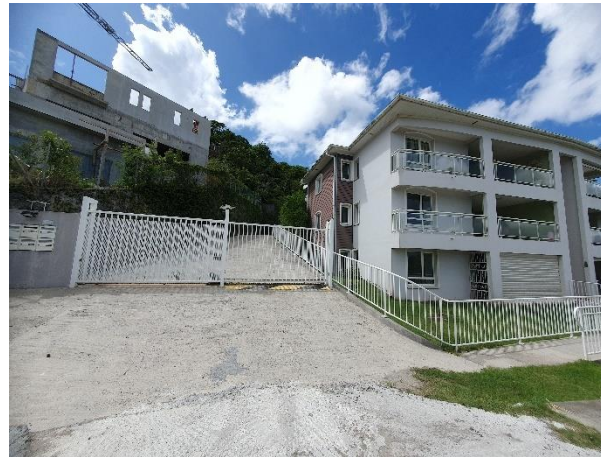
16 – Résidence en surplomb du terrain
