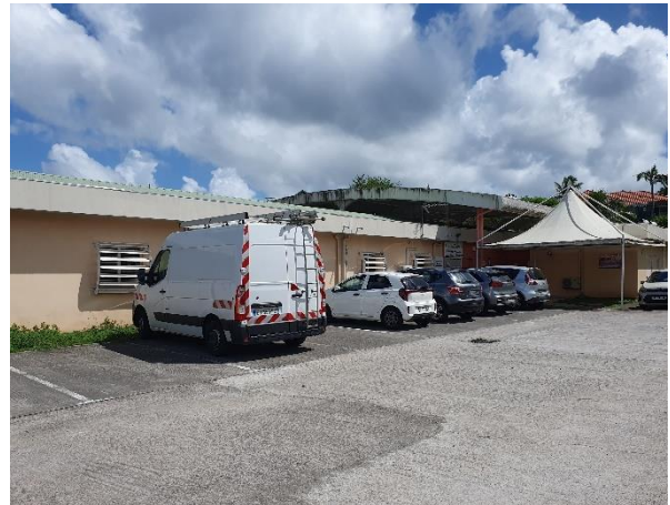
26 – Collecte des EP côté parking
