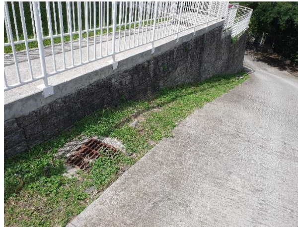
32 – Collecte des EP sous la résidence Tangarane
