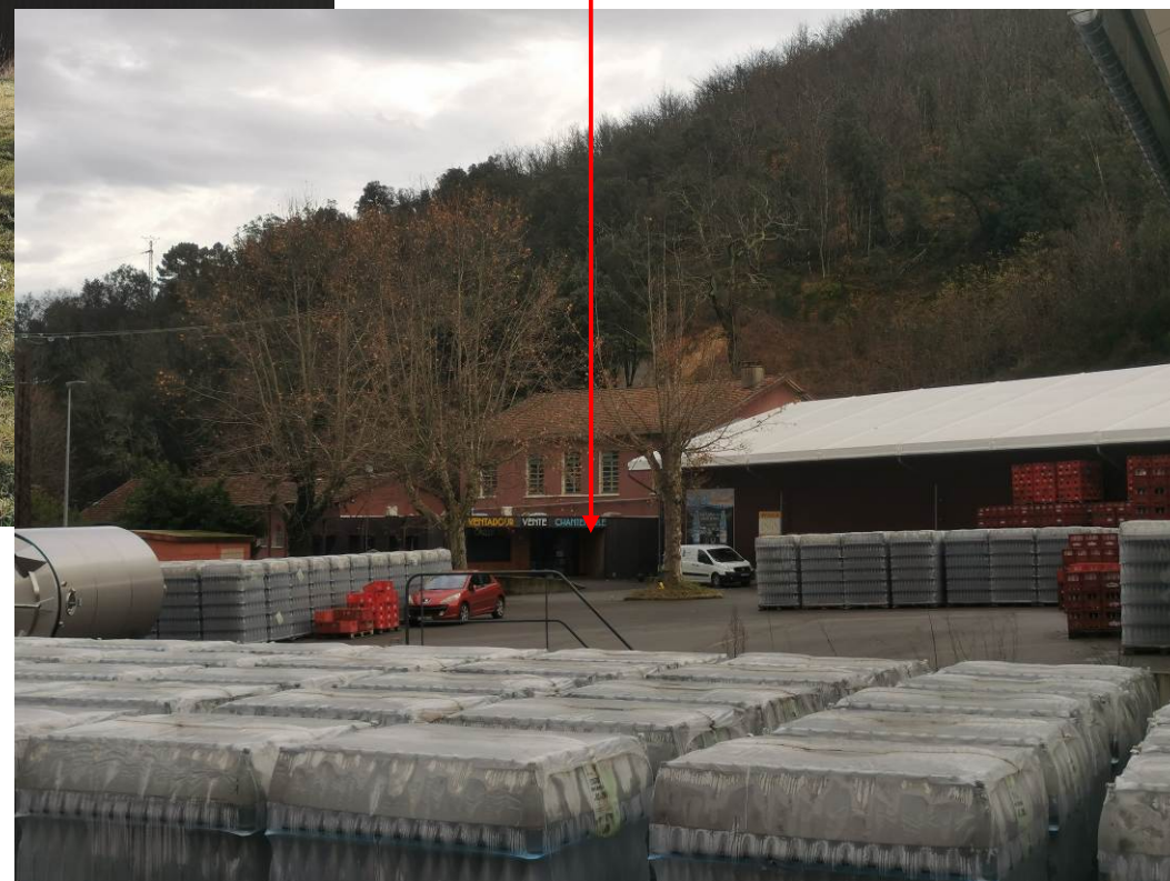
Forage F3 dans le bâtiment
