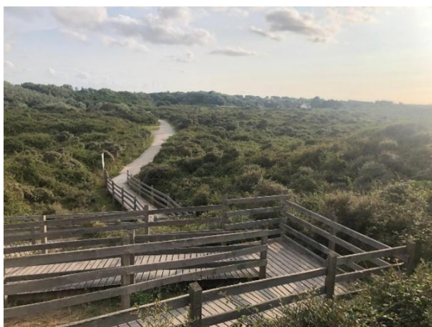
Figure 1 : Passerelle par le parking de la plage des Ecardines, photo prise le 20 août 2024.
