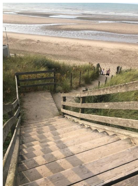
Figure 2 : Escalier par le parking de la plage des Ecardines, photo prise le 20 août 2024.
