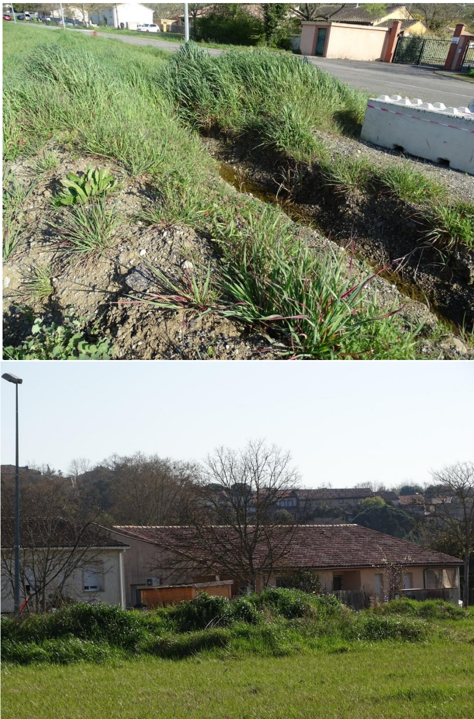
Figure 20 : Merlons, terrain remanié le long de la parcelle (Source : ADRET Nature, 2026)
