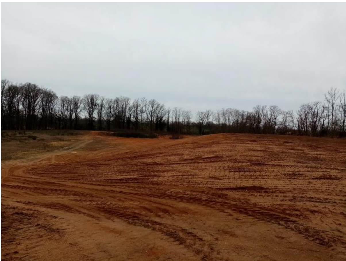
Figure 7. Prise de vue montrant le terrassement effectué en fin de période d'exploitation pour aplanir les fronts de taille. La flèche rouge montre les traces laissées par les chenilles lors de cette opération. Source : NCA Environnement.
