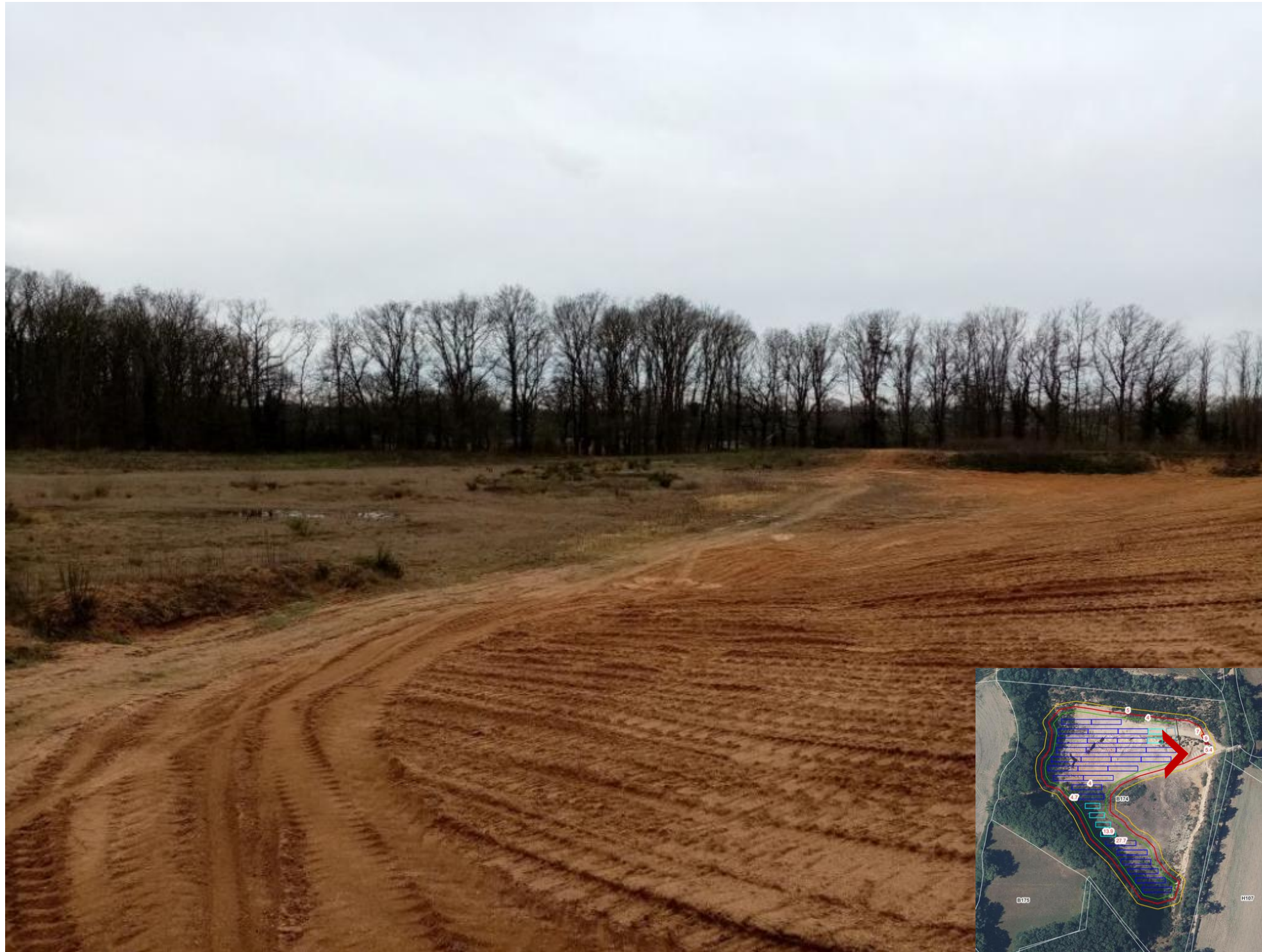
Photo 1 : Photographie proche datant d'avril 2024 (source NCA environnement)
