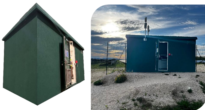
Figure 4 : Exemple d'un poste de livraison (Source : Energiter)
