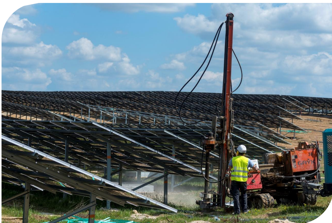
Figure 6 : Foreuse de pieux (Source : Energiter, Centrale solaire de Baignolet)
