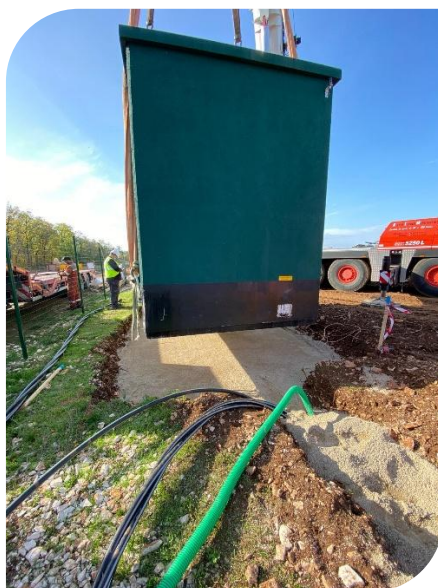
Figure 8 : Pose des postes électriques (Source : Energiter, Centrale solaire de Goussaincourt)
