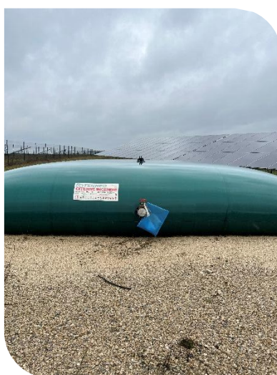
Figure 5 : Exemple de réserve incendie (Source : Energiter)
