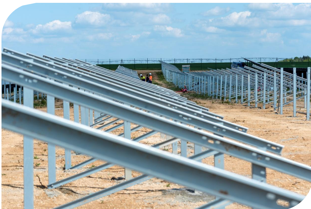
Figure 7 : Pose des panneaux et des structures (Source : Energiter, Centrale solaire de Baignolet)
