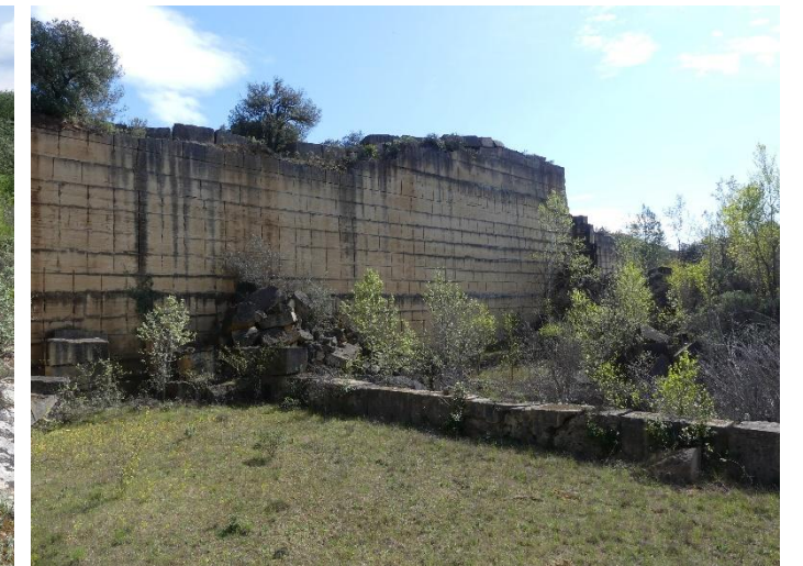
Front vertical de l'ancienne carrière sur le site d'étude
